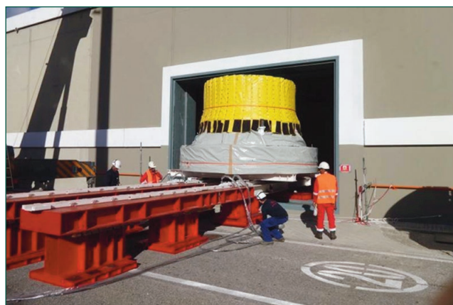
Figura 9. Entrada de la tapa en el Almacén de Residuos.
