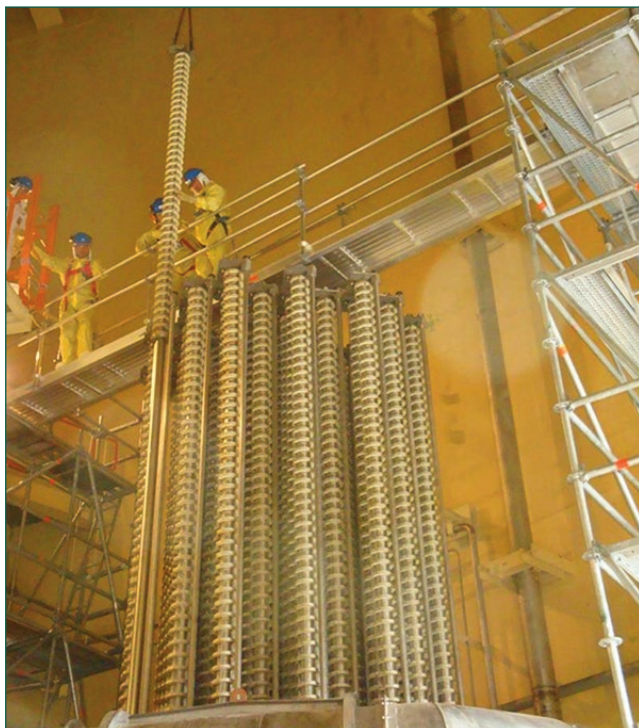
Figura 4. Distribución de andamios y desmontaje de bobinas DRPI.
