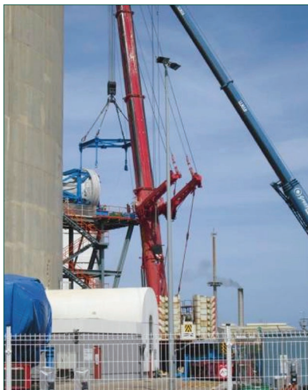
Figura 5. Salida de la tapa por la Esclusa de Equipos.
