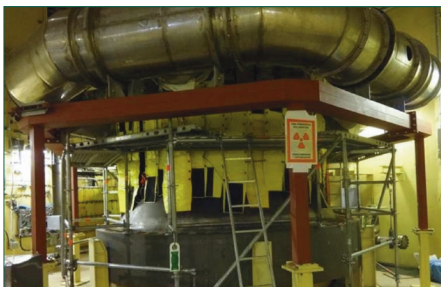
Figura 3. Disposición de blindajes en el escudo.
