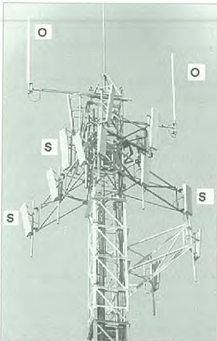
Figura 3: Antenas montadas en la torre de una estación base en una zona rural. O: Antenas omnidireccionales, de sección transversal circular. S: Antenas sectoriales; sección rectangular.
