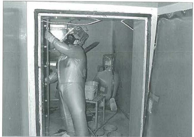
Trabajos de dismantelamiento y descontaminación. Celda de combustible
