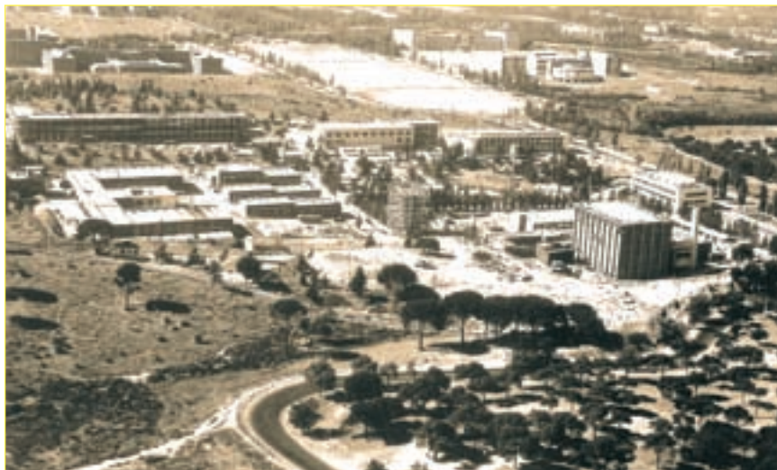
Vista aérea de las primeras instalaciones del CIEMAT
