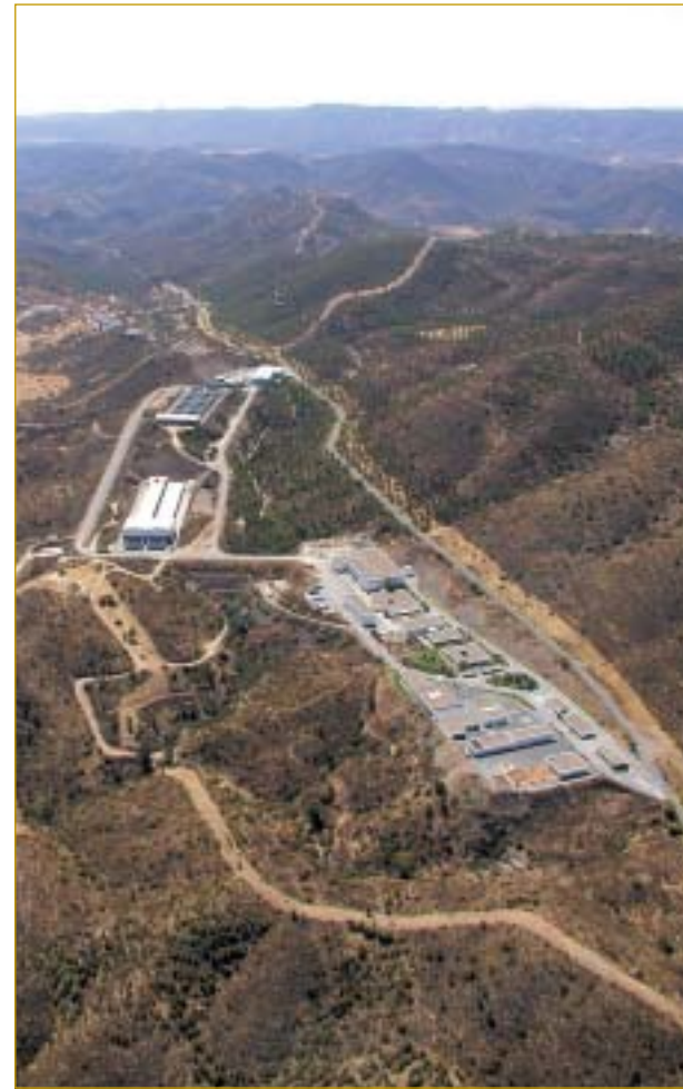
Vista aérea de El Cabril. Aerial view of El Cabril.
