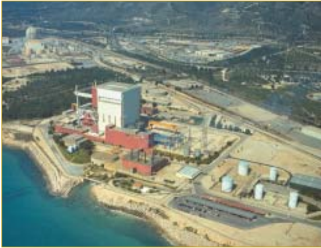
La central nuclear Vandellós I en operación. Vandellós I nuclear power plant in operation.
