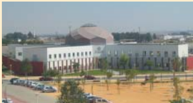
Vista general de la Facultad de Derecho de la Universidad de Huelva.
