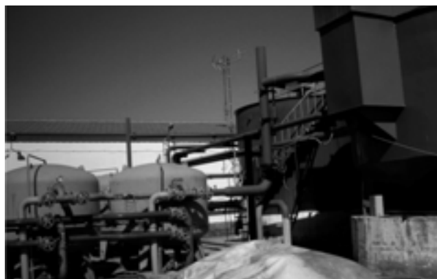
Planta de tratamiento de agua potable a una población en la que se aplican modificaciones para eliminar gran parte del contenido en uranio que posee dicha agua.
