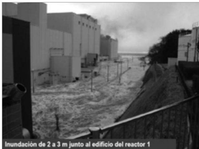
Figura 2. Inundación debida al tsunami junto al edificio de la Unidad 1.
