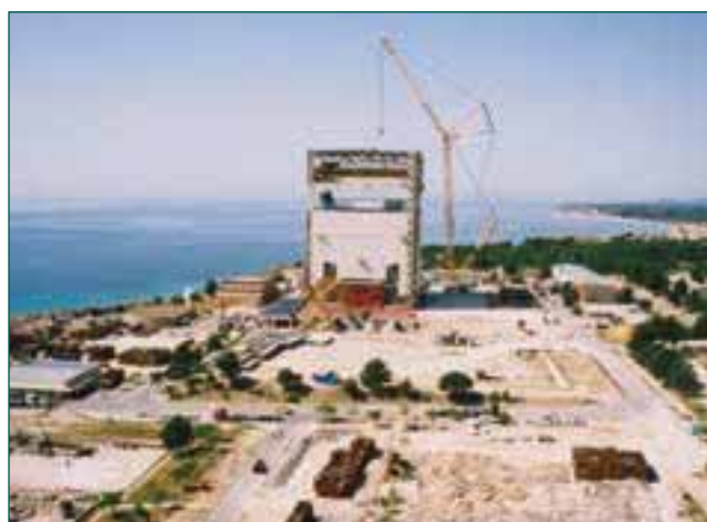
Figura 1: Desmantelamiento del antiguo edificio del reactor de la C.N. Vandellós 1.
