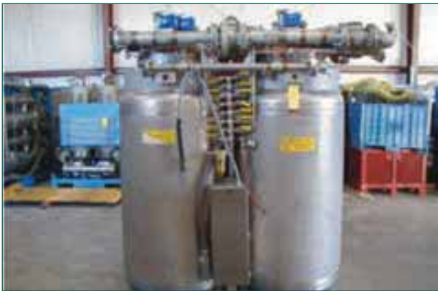
Figura 2. Descontaminación circuito primario.
