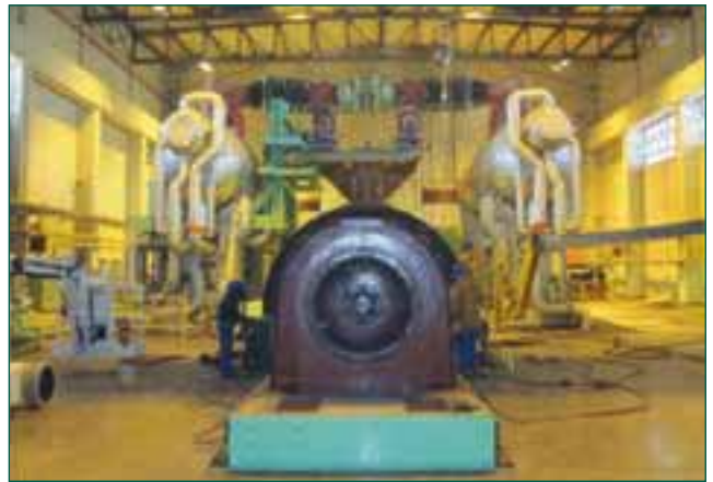
Figura 4. Antiguo edificio de turbinas.
