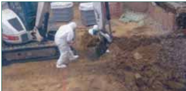
Figura 3. Retirada de terrenos.
