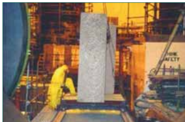
Figura 9. Troceado de hormigón.
