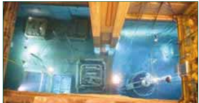
Figura 5. Corte de los internos del reactor.
