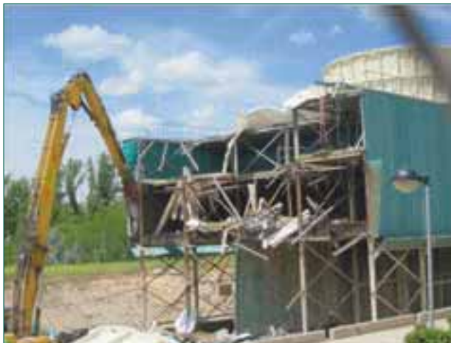
Figura 3. Desmontaje de las Torres de Refrigeración.
