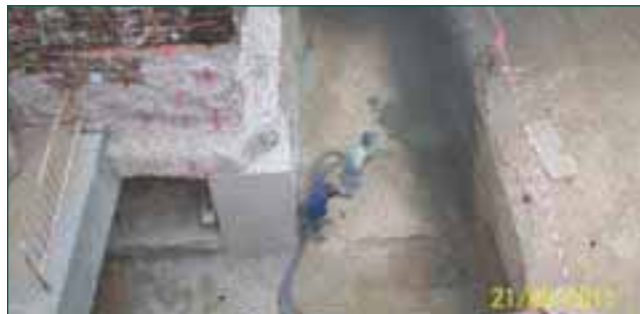
Figura 6. Aislamiento de cavidad con gunita.
