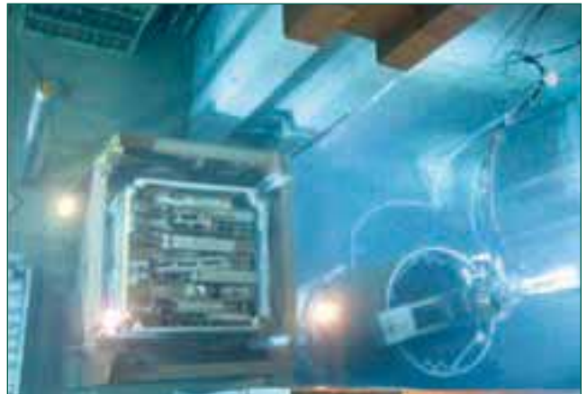
Figura 5. Cavidades donde se ha realizado el corte bajo agua del reactor de CN José Cabrera.
