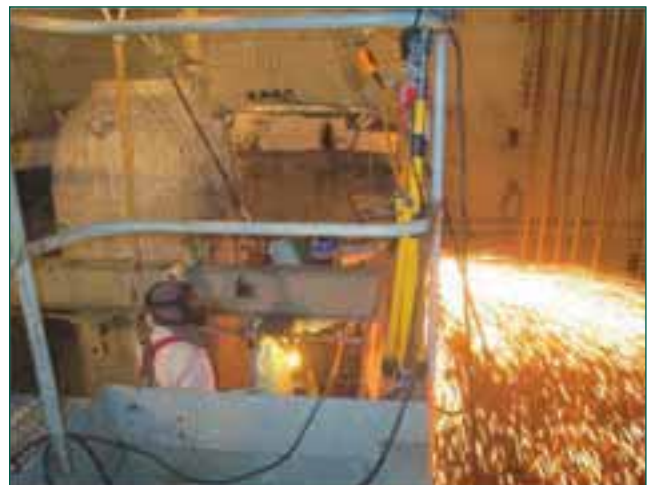
Figura 7. Desmontaje del presionador del circuito primario.
