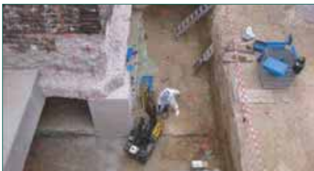
Figura 5. Sondeos en el fondo de excavación.
