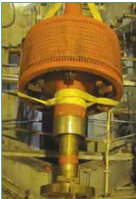
Figura 4. Extracción del rotor de la bomba de recirculación del primario.
