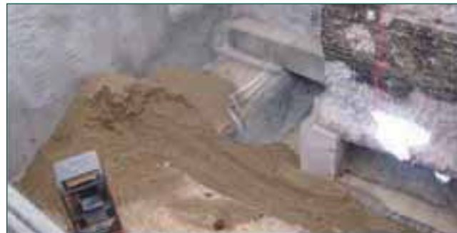
Fig 7. Inicio del relleno del hueco.
