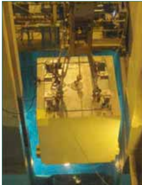
Figura 6. Descenso de la campana de blindaje para extracción de los residuos del reactor.
