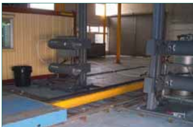
Figura 10. Instalaciones de desclasificación.
