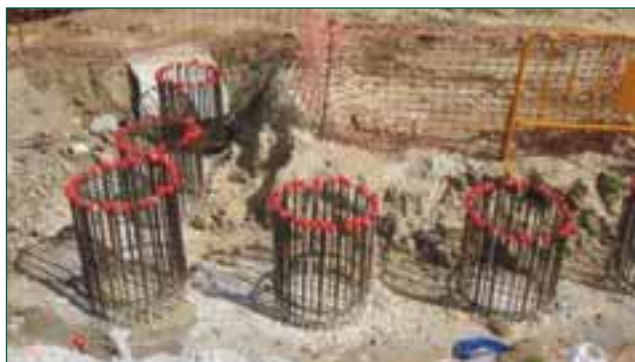
Figura 1. Construcción pantalla de pilotes.
