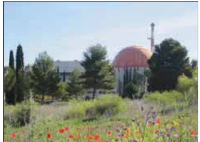
Figura 1. Vista exterior de la Central Nuclear José Cabrera.
