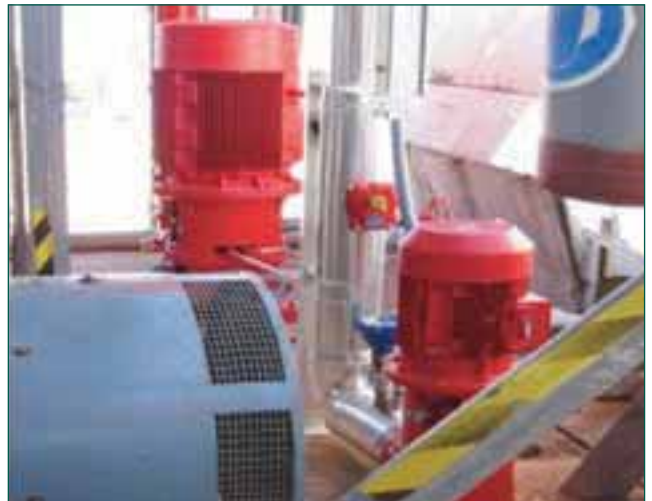
Figura 3. Sistema bombeo PCI.
