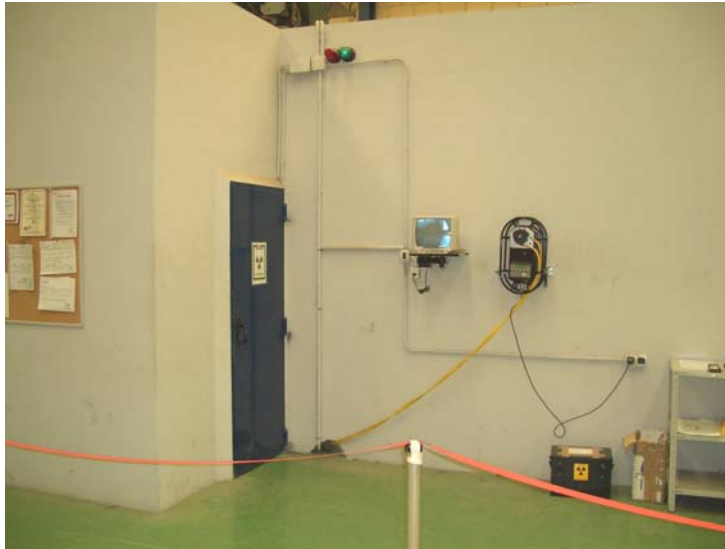
Condiciones de Trabajo en Instalación Fija: Bunker
