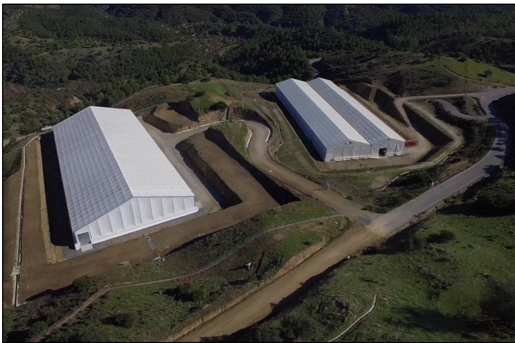
Figura 14. Instalación complementaria para el almacenamiento de RBBA
