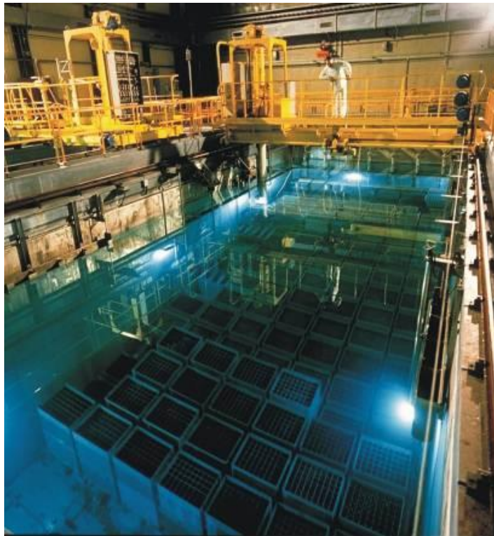
Figura 15. Piscina de almacenamiento de CG
