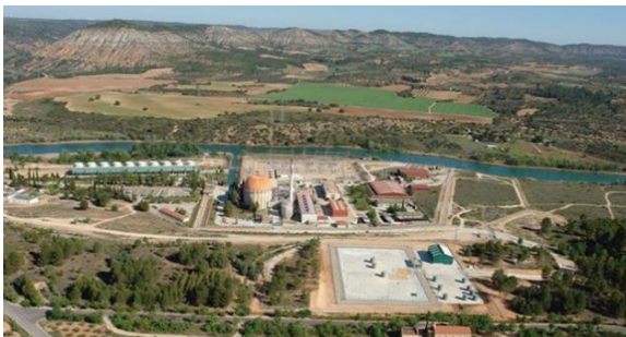
Figura 23. Aspecto del desmantelamiento de CN José Cabrera: antes y después (figurado) del desmantelamiento total
