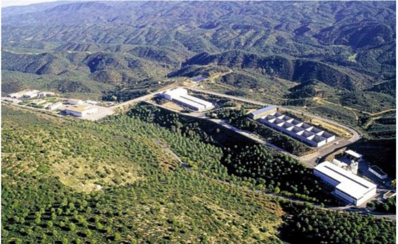
VISTA AÉREA DE LA INSTALACIÓN
