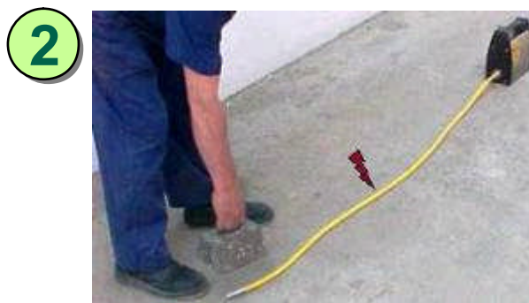
2 Colocar una teja u otro elemento de blindaje sobre la ubicación del portafuentes
