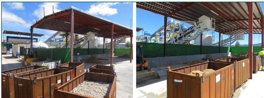
**Foto 2.** Contenedores con gravas y arenas previamente a su envío a control radiológico para desclasificación.
